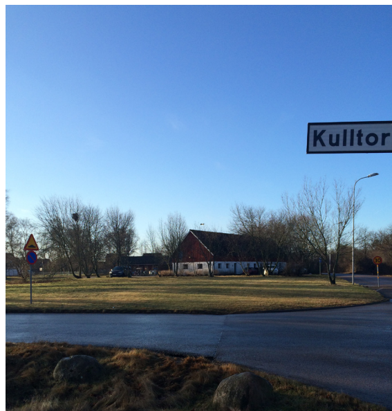
Förskolan på fastigheten Råkan 2. Gräsytan framför är den del av fastigheten som inte används och som tas i anspråk för väg.
